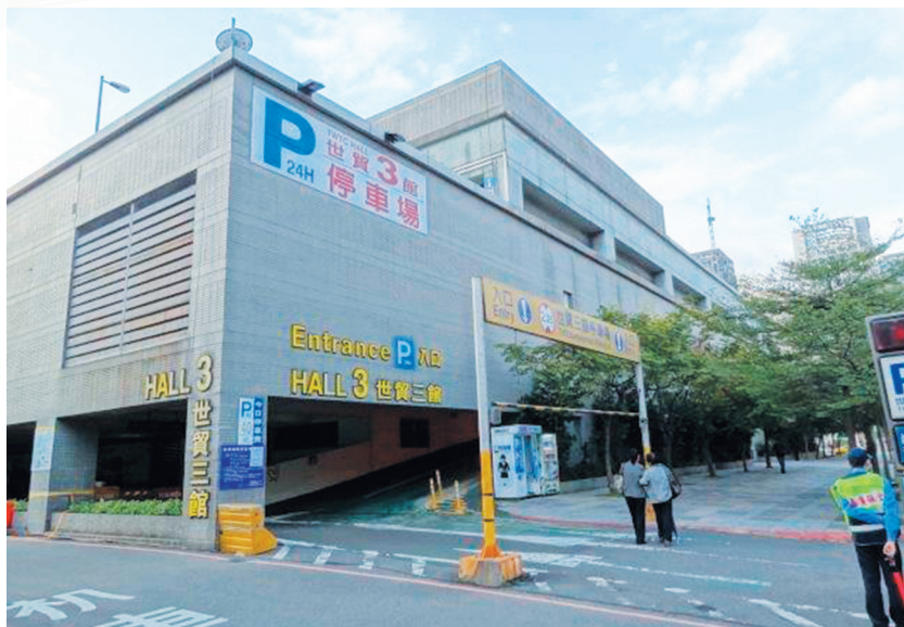
● 國有財產開發基金投資性不動產－世貿三館
